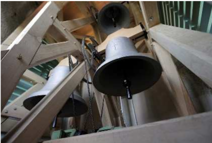
Der fertiggestellte Glockenstuhl!
